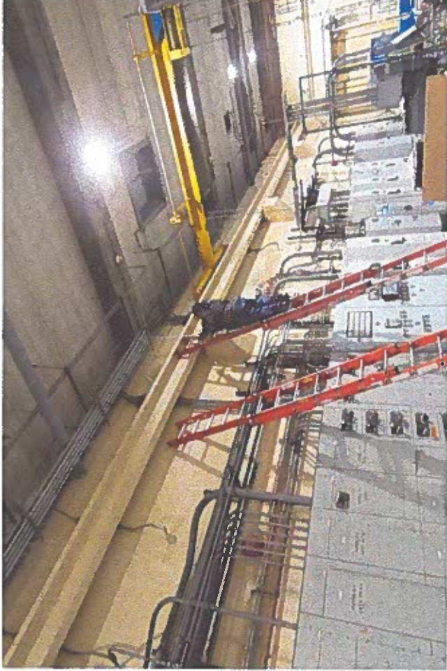
Laying out conduit route (2-23-24)
